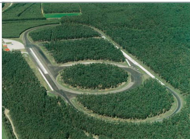
75.000 Quadratmeter Land wurde für die neue Testbahn erschlossen
